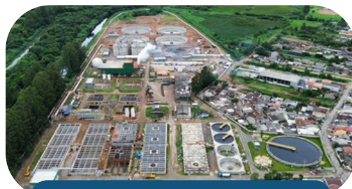
SES Curitiba - ETE Atuba Sul
